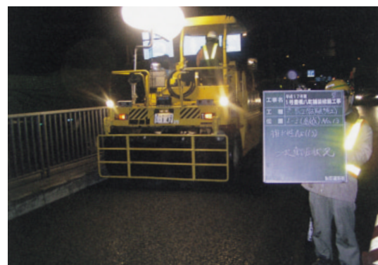
第4図 施工状況
