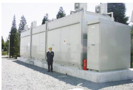
高圧電気二重層キャパシタ式瞬低補償装置
