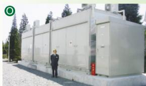
高電圧電気二重層キャパシタ式瞬低補償装置
