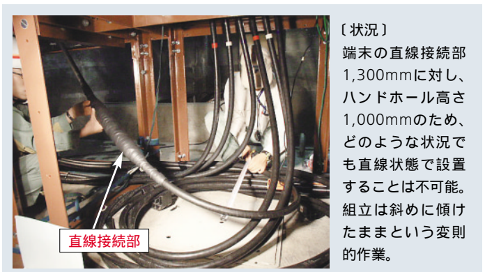
第1図 差込式直線接続部(1相)の設置状況
