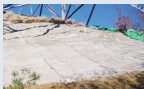
種子付ネットを施設し、ネットの端を杭でとめる
