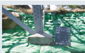
敷地に敷き並べる
