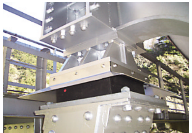
第6図 免震ゴム支承の設置状況
