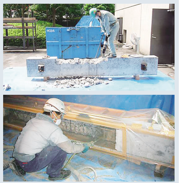
第2図 試験体作製状況 (上: はつり作業、下: 断面修復工)
