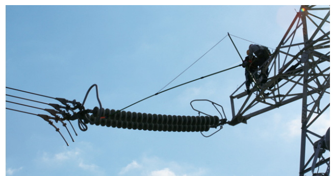
第3図 長尺ポールの適用検証状況
