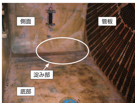
第2図 内部清掃後のリターン室
