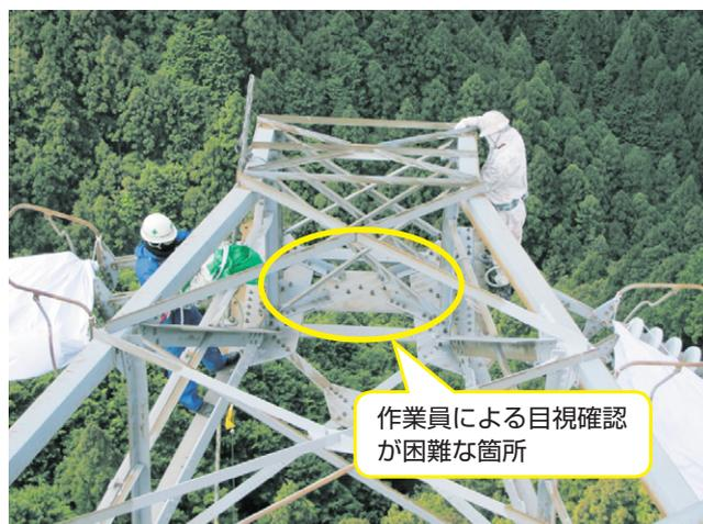
第2図 大型鉄塔耐張型腕金の先端部
