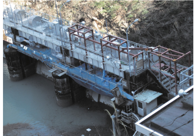
第6図 門構設置状況(奥泉ダム)
