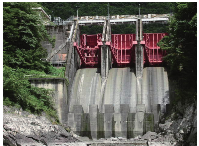
第2図 ダムの洪水吐ゲート、水門柱、既設橋梁(奥泉ダム)
