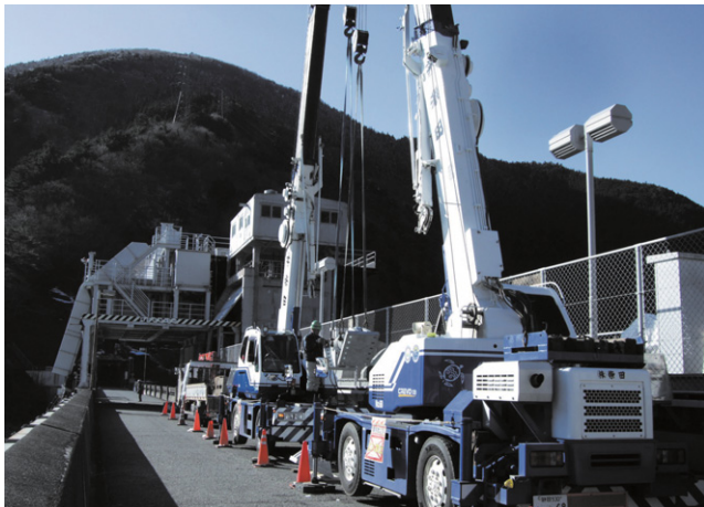
第4図 クレーンによる相吊り作業状況(井川ダム)
