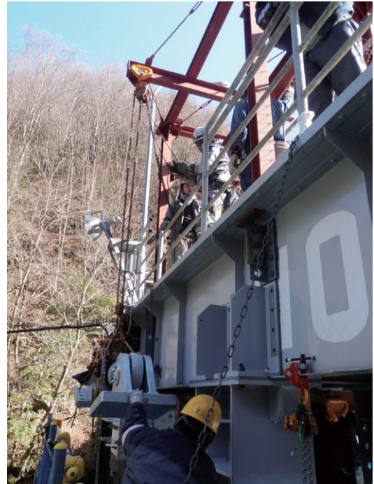
第7図 部材吊卸し状況(奥泉ダム)
