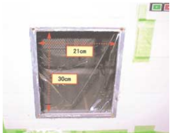
写真2 電解穿孔法による切断状況
