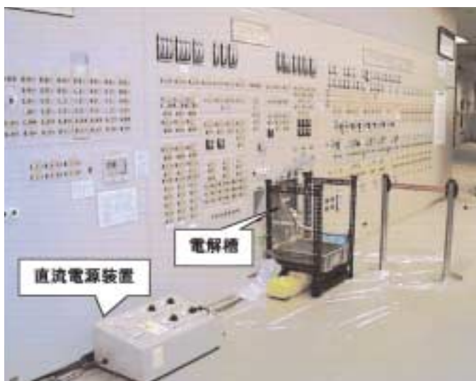
写真1 電解穿孔装置設置状況
