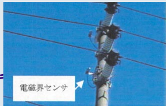
第8図 電磁界センサ装柱状況
