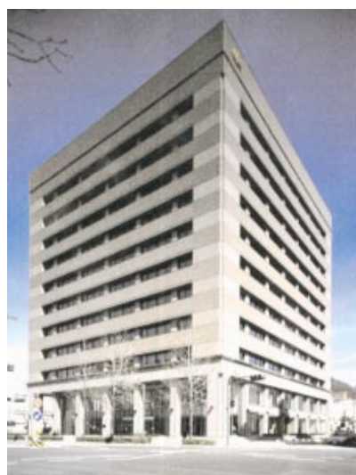
第1図 岐阜ビル全景
