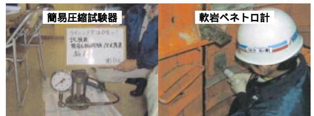
第8図 型枠脱型時の強度確認方法
