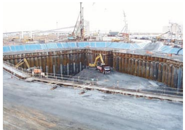
第2図 取水槽掘削状況
