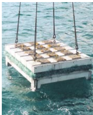
コンクリート製の藻礁(3トン)を布設している状況(1997年12月)
