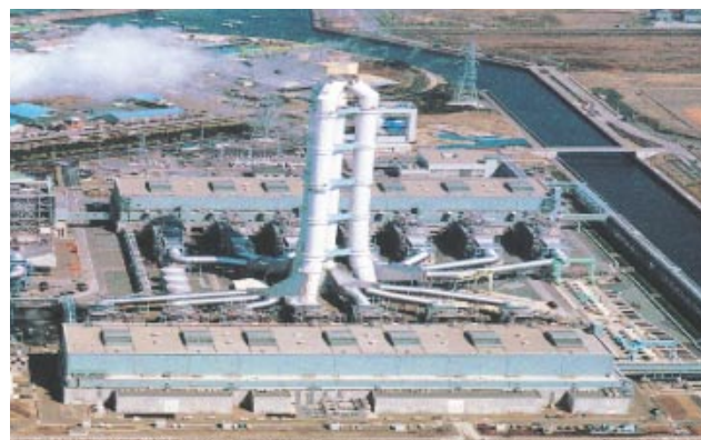
第2図 多軸通煙煙突(川越火力発電所)
