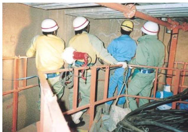
第1図 ゴンドラによるライニング点検
