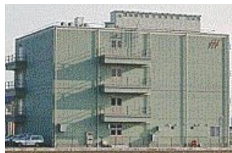
技術開発センター外観
