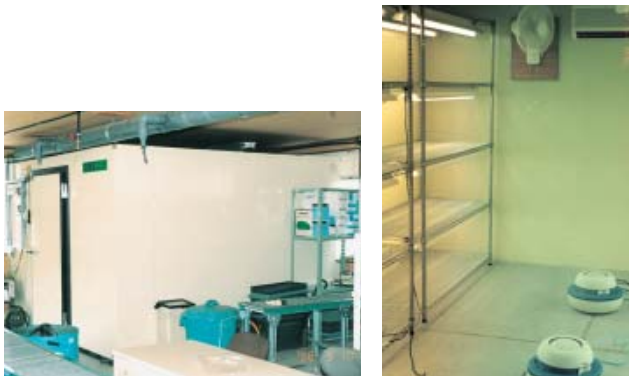
写真1 初期育苗ユニットの外観と内部
