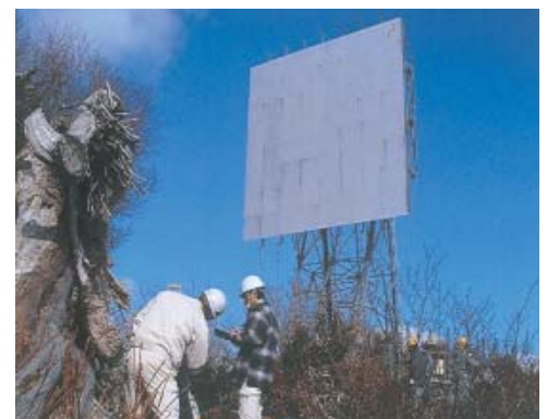
レーザーによる反射板板面測定
