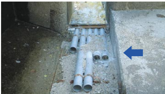
第3図 沈砂池排砂装置
