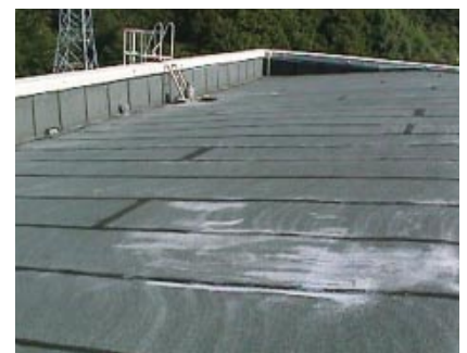
第9図 アスファルト屋根防水
