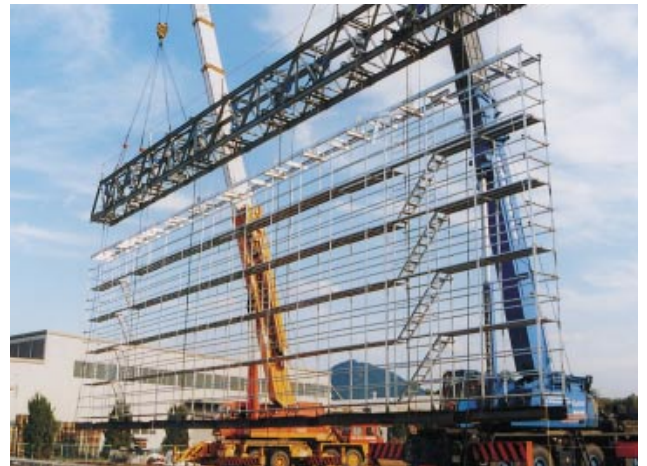
第7図 実証試験状況 (巻上機能確認中)
