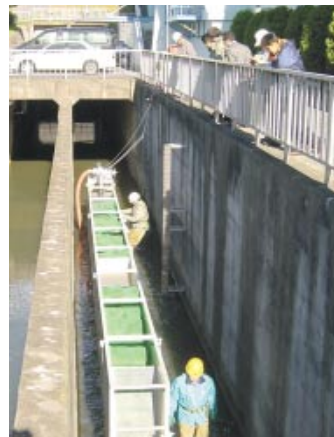
第2図 試験水路設置状況
