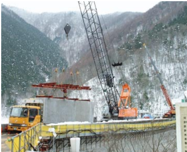
写真2 プレキャスト型枠搬入状況
