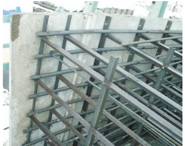
写真3 函体変形防止補強鋼材
