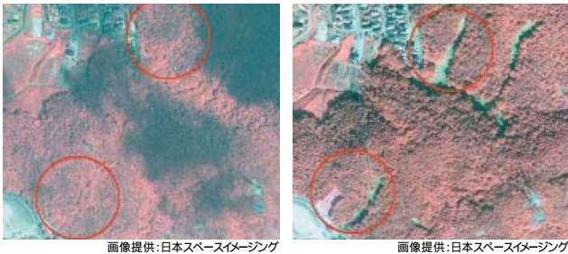
第5図 崩落前(左)と崩落後(右)
