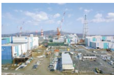
写真1 六ヶ所再処理工場の建設状況
