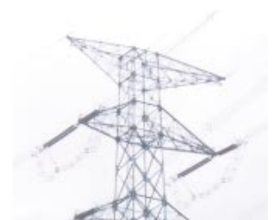
275kV (500kV設計) 音羽新三河線 NO.19号鉄塔 ビックアップジャンパ装置
