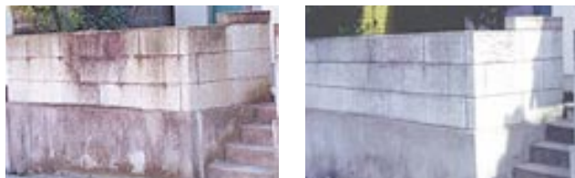
写真2 コレトレール施工例 (左:施行前 右:施行後6ヶ月)
