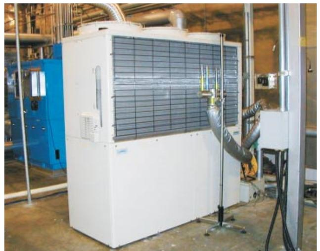
第7図 ガスエンジン式ビル用マルチエアコン
