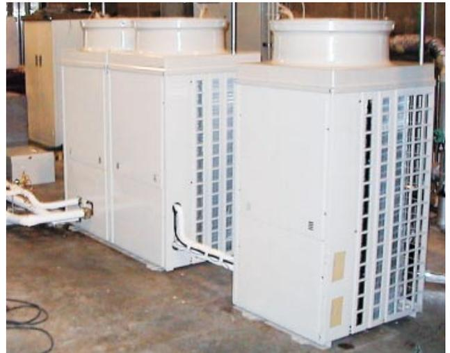
第6図 電気式ビル用マルチエアコン
