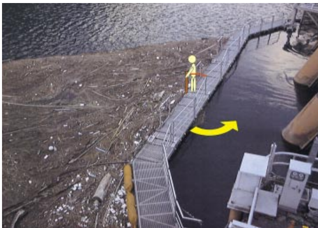
第1図 水位追従型網場における塵芥除去作業
