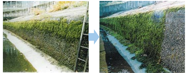
写真2 導水路(左:施工前 右:施工後2年目)
