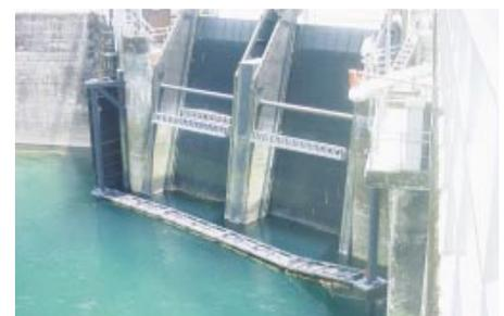
水位追従型吊上式網場(吊上状態)
