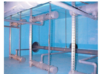
第2図 温度成層型蓄熱槽
