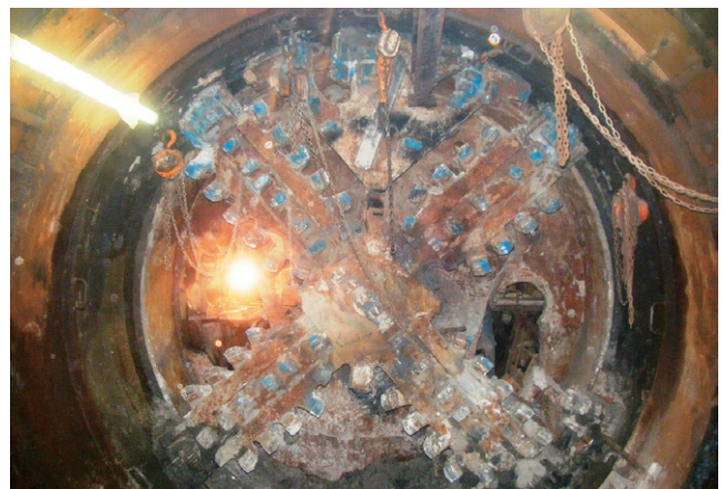
第6図 地中接合点に到達した川越側シールドマシン
