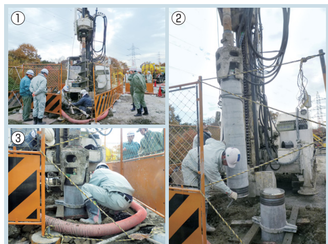
第4図 施工技術試験状況（東海コンクリート工業（株）三重工場） ①プレボーリング（掘削）・②杭の継ぎ作業・③杭の建て込み
