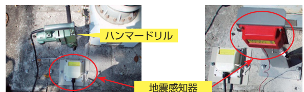
第4図 ハツリ作業の影響確認試験
