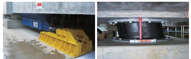
第4図 油圧ジャッキと加振された積層ゴム
