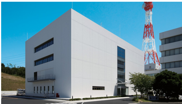
第1図 事務本館別館(免震棟)外観
