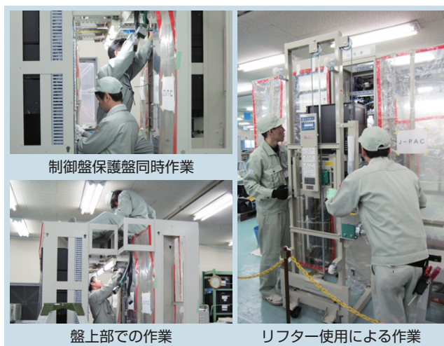
第3図 ユニット取替作業風景
