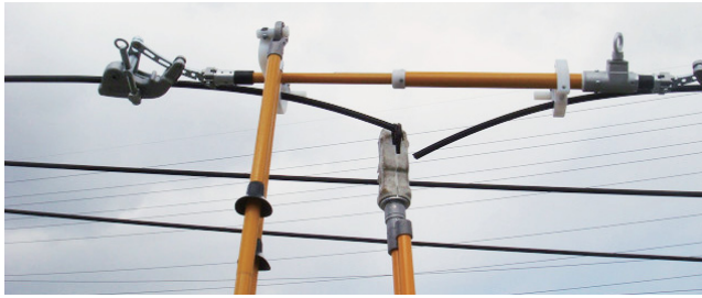
第2図 柱間切分工法の実施状況
