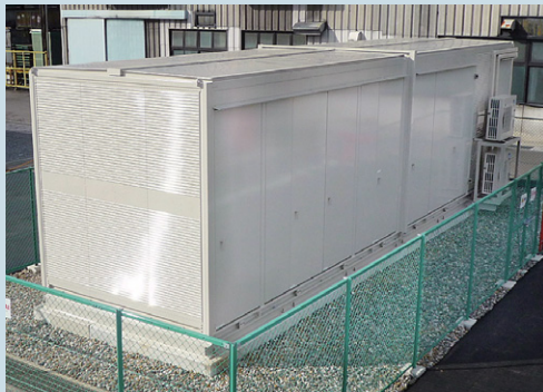
(a) 短時間停電補償装置の実証器
