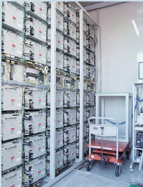
(b) リチウムイオンキャパシタ盤(実証器の一部)
