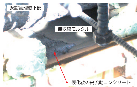
第7図 材料投入口からの無収縮モルタルの充填状況
