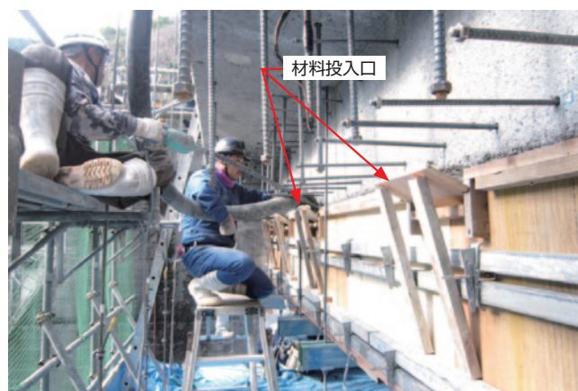
第6図 コンクリートの打設状況
