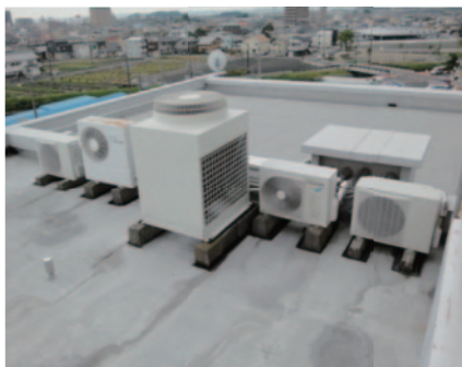
第1図 建物屋上状況
