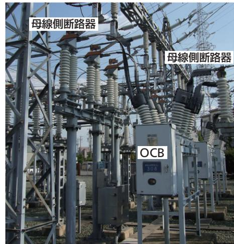
第2図 33kV OCBレイアウト例
