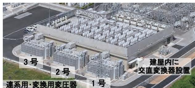
第6図 東信変電所STATCOMの設置状況
