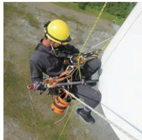
第2図 ロープワークでの導通確認点検
