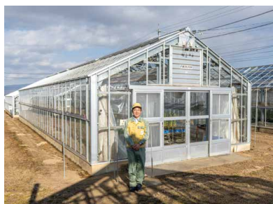
基礎試験を実施した試験温室(長野県野菜花き試験場の構内)
