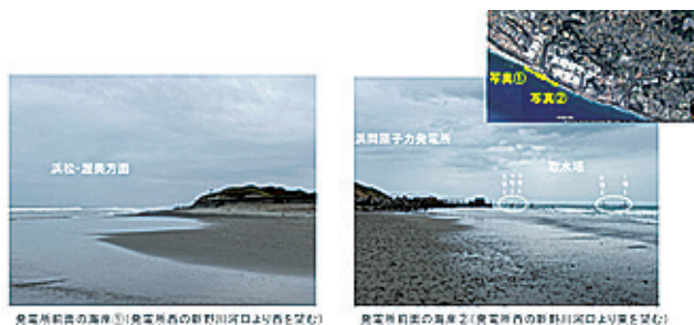
第1図 浜岡原子力発電所前面海岸状況
