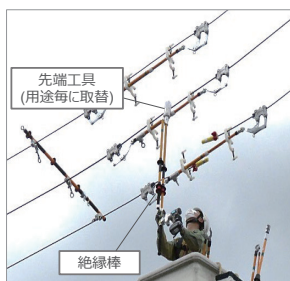
第3図 間接活線工法の例
