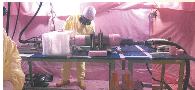
第6図 除染装置試験状況
